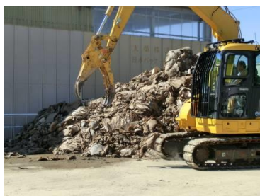
水浸しの段ボール
